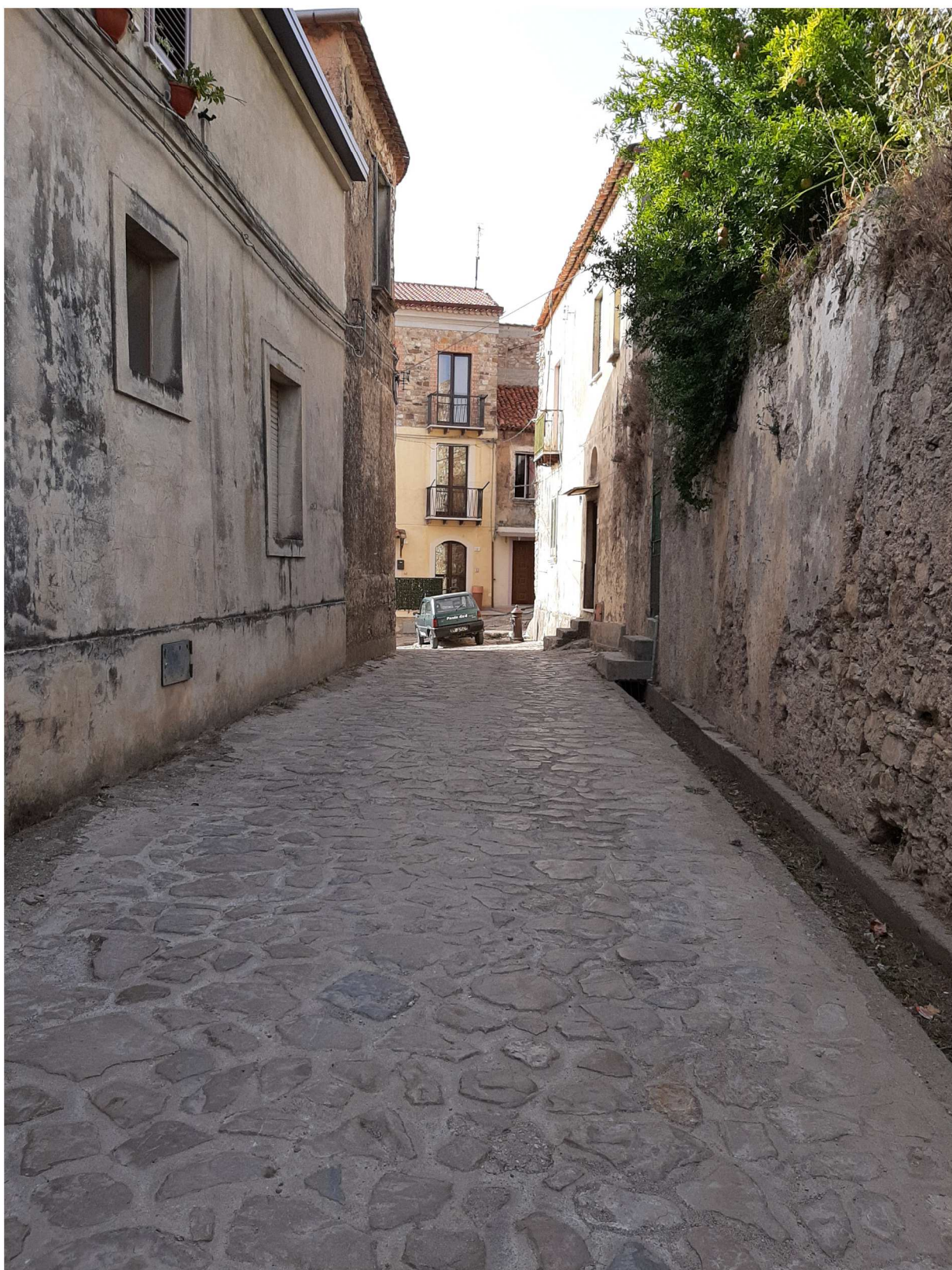
Foto 1 Stato di fatto del Tratto "N - O" con particolare dei basoli in pietra e la cunetta di scolo delle acque piovane addossata alle pareti dei fabbricati
