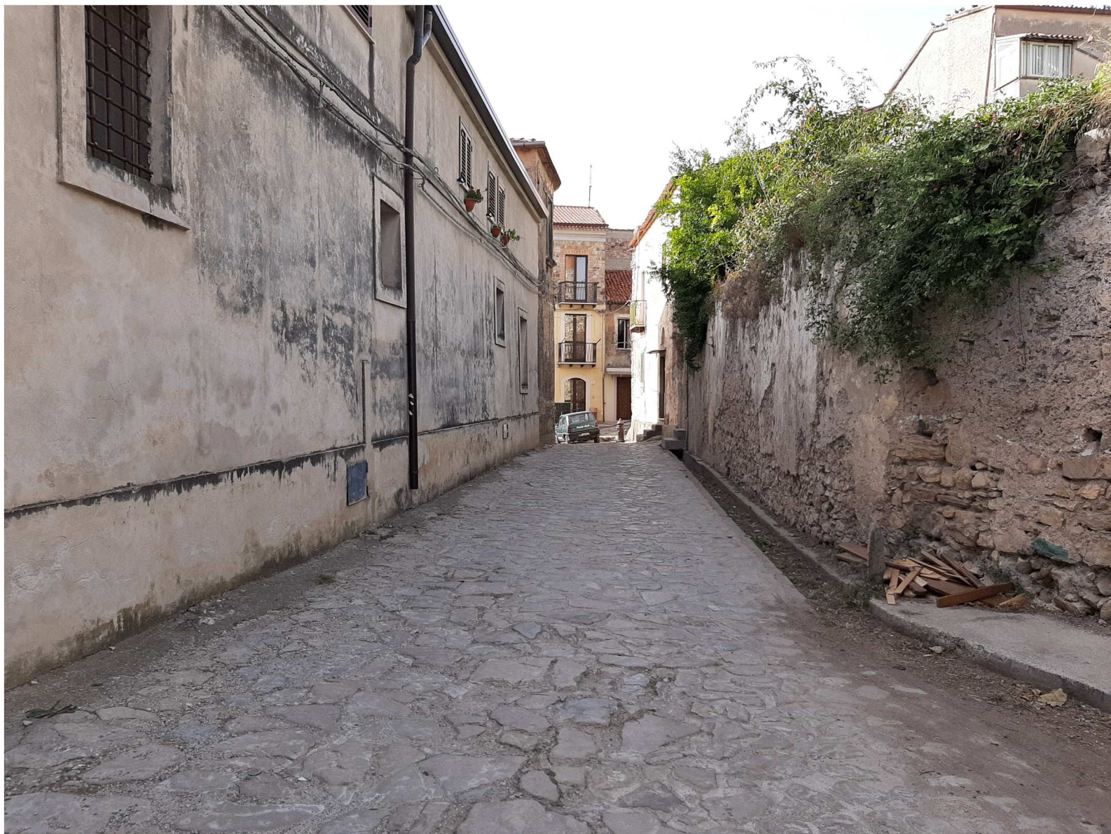
Foto 2 Stato di fatto del Tratto "N - O" con particolare dei basoli in pietra e la cunetta di scolo delle acque piovane addossata alle pareti dei fabbricati
